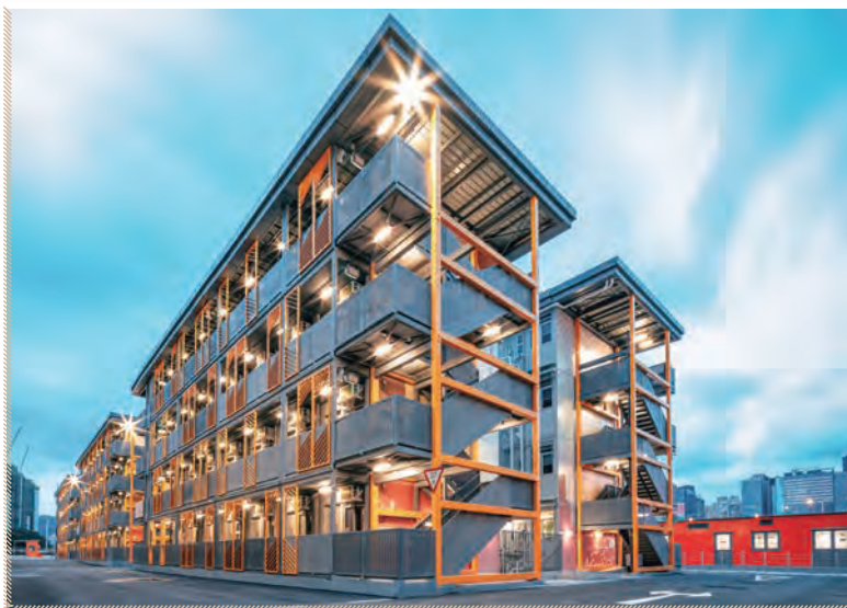
■ 啟德郵輪碼頭社區隔離設施
