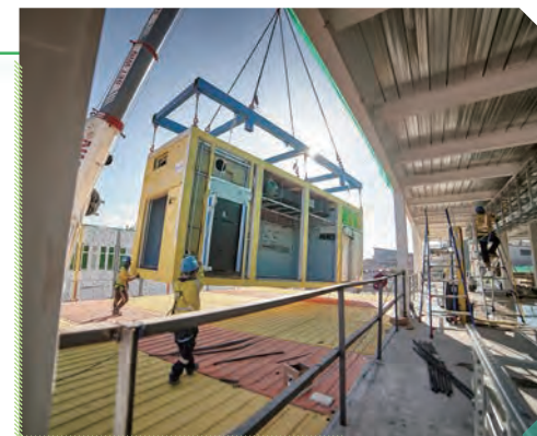
■ MiC施工現場
