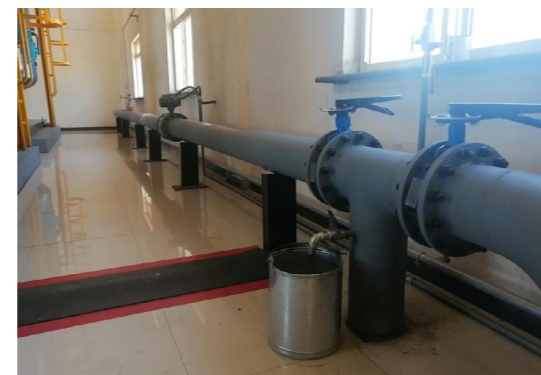
月東油田污水外輸系統
