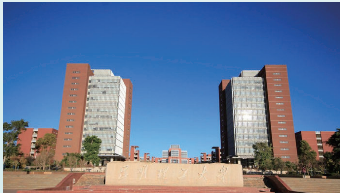
昆明理工大學社區中心學生公寓熱水改造項目
