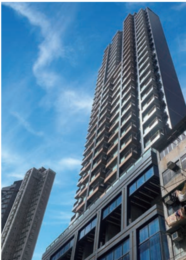
已於二零二二年八月竣工
