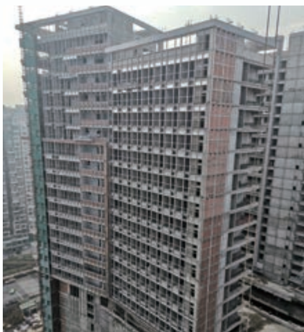
富豪國際新都薈之商業/ 寫字樓大樓之上蓋工程正在進行中
