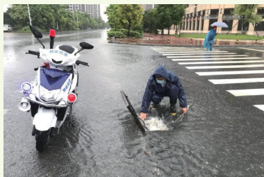
管家疏通排水系統現場 Butlers unblocking drainage system
