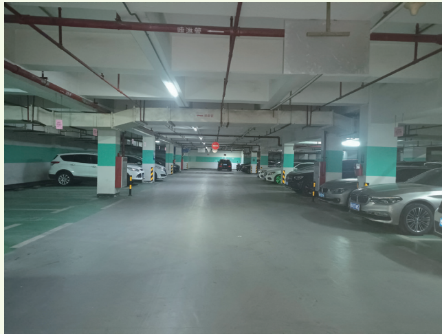
廣州時代雅苑地下車庫現場 Underground garage of Guangzhou Times Yayuan
