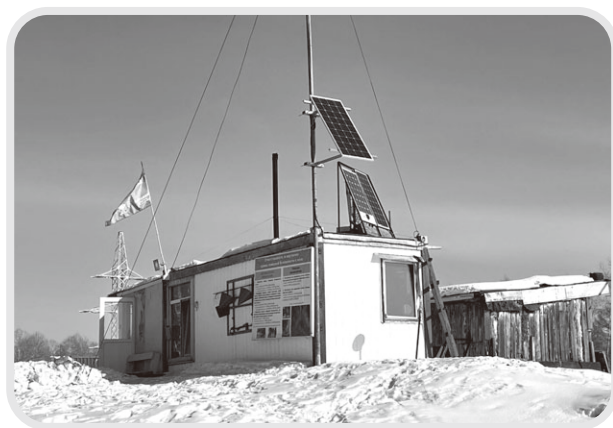
已安裝太陽能電池板的哨站。
