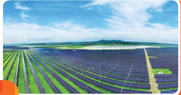
沽源「光伏+」示範項目
