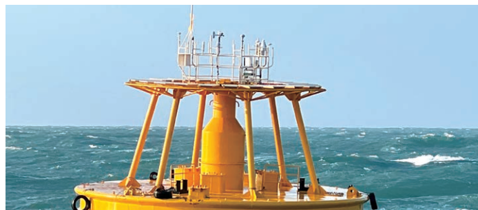
海南乐东600MW海上风电项目测风塔
