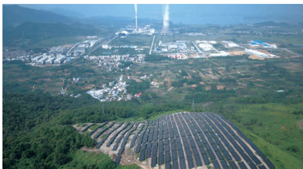
富川瑶族自治县牛背岭60MW光伏项目
