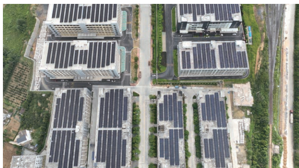
贺州华润循环经济产业示范区15.2MW分布式光伏项目
