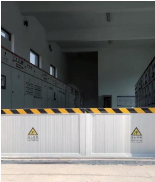
奥盛新材料在电气控制室门加装防鼠板
