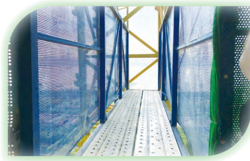
塔吊定型化通道 Tower Crane Type-fixed Channel
