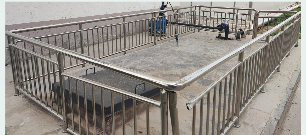
蒸汽冷凝水回收再利用項目
