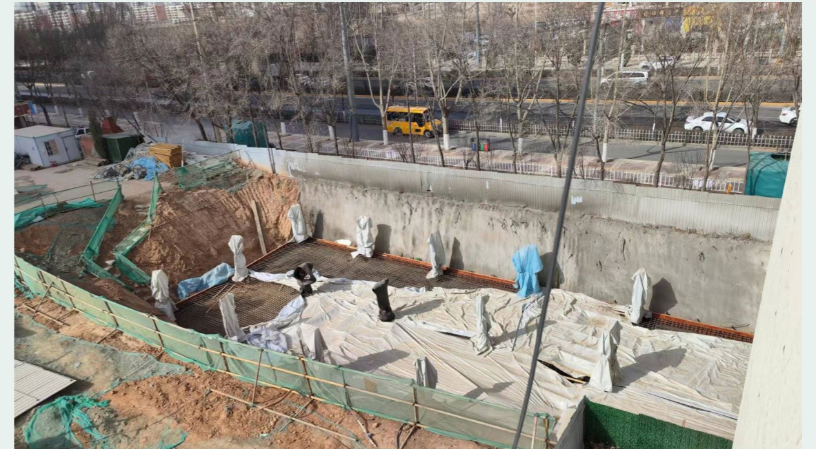
污水站擴容加中水回用（在建）
