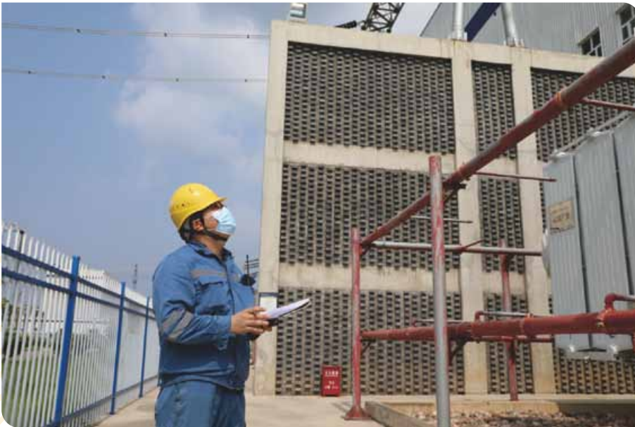
◀ 迎峰度夏期間商丘熱電發電機組檢修
