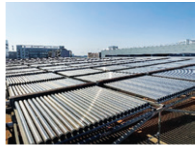
太陽能管制熱系統修復實景圖
