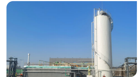
天津某工廠新建污水處理站
