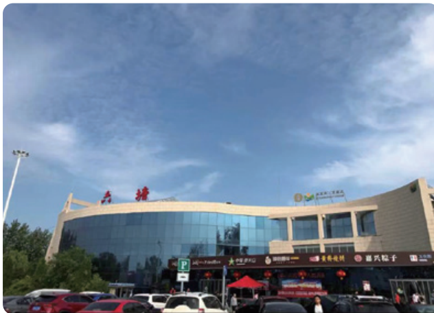
Newly entered city in 2022: Lianyungang Liutang expressway service area 2022年新進入城市： 連雲港六塘服務區
