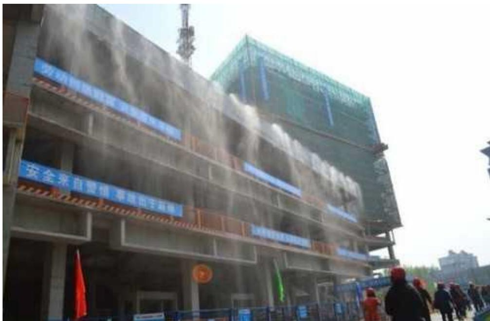
施工現場的主要道路及材料加工區地面應進行硬化處理，道路應暢通，路面應平整堅實。裸露的場地和堆放的土方應採取覆蓋、固化或綠化等措施。施工現場出入口應設置車輛沖洗設施，並對駛出車輛進行清洗。世茂會定期清運建築垃圾，土方和建築垃圾的運輸應採用封閉式運輸車輛或採取覆蓋措施。建築物內施工垃圾的清運，應採用器具或管道運輸，嚴禁隨意拋擲。施工現場嚴禁焚燒各類廢棄物。加強現場監測監控，鼓勵施工工地安裝線上監測和視頻監控設備，並與當地有關主管部門聯網。當環境空氣質量指數達到中度及以上污染時，施工現場應增加灑水頻次，加強覆蓋措施，減少易造成大氣污染的施工作業。
