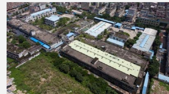
五聯一期更新改造前實景 Wulian Phase I: Before renewal
