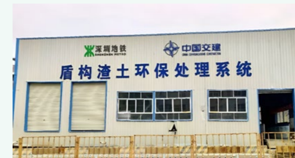
盾构渣土分离系统 Shield muck separation system
