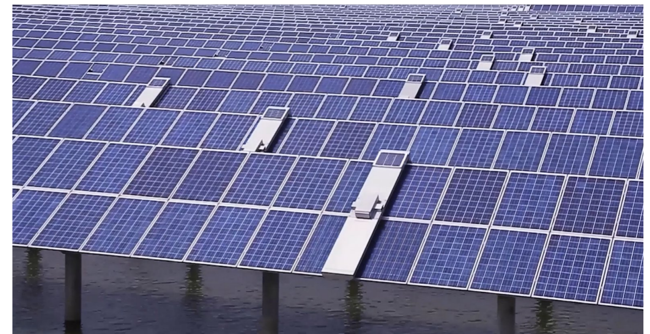
圖：本集團應用的智能運維機器人，極大地降低運維過程中用水量。
