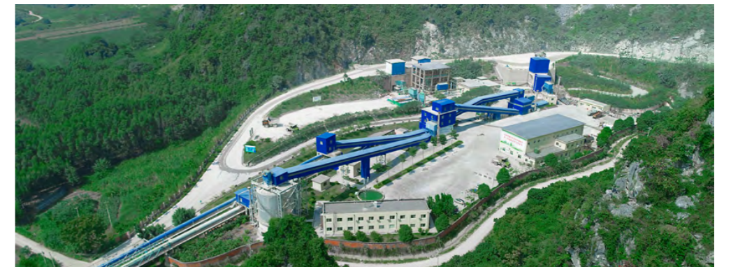
南宁水泥矿山
