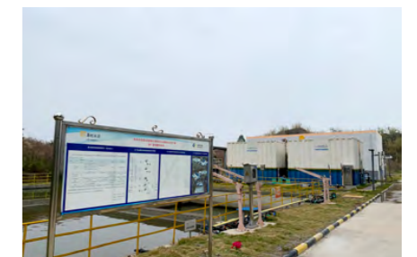
陆川水泥废水零排项目
