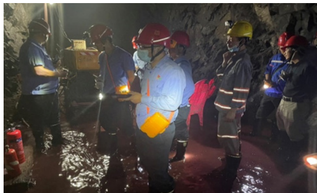
外委單位施工現場安全檢查
