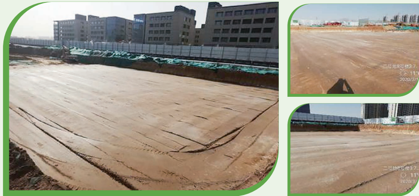
長沙項目灰土回填
