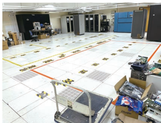
拆除網絡設備後，釋放更多空間。
