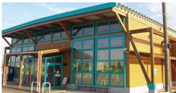
第二代木製建築遊戲館：一九九五年（富山縣小杉町遊戲館）將外牆改為木製外牆面板。此外，木材的使用增加。已安裝遊戲機數目：480台
