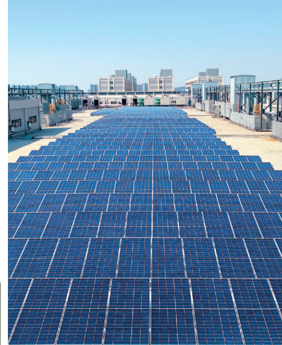
2022年10月在江門的廠區安裝太陽能電池板
