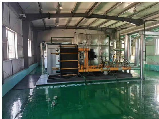
換熱站乃為從一級輸配管網向二級輸配管網輸送熱量而建造。該等換熱站配備換熱器、循環泵、補水泵、閥門、儀器、儀表、過濾器、水箱、配電櫃、控制櫃以及水處理設備。
