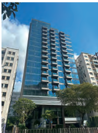
Residential development at 233-235 Prince Edward Road West, Kowloon 九龍太子道西 233-235號之住宅發展項目
