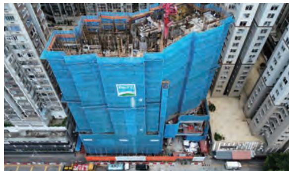
Composite development at No. 11 Ngau Tau Kok Road, Kowloon 九龍牛頭角道11號之綜合發展項目
