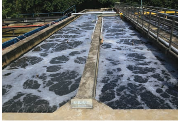
污水處理設施
