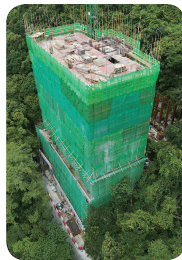
▲ 上蓋建築工程施工中 該照片攝於 2023 年 6 月 21 日，並已使用電腦影像技術進行編輯及處理。
