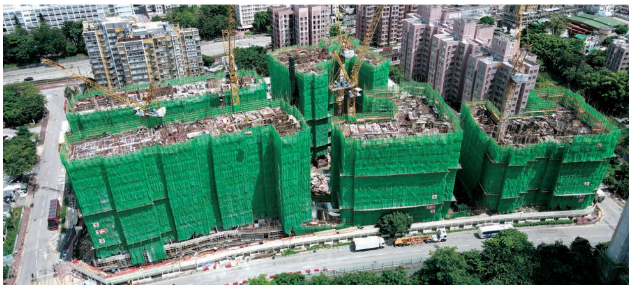
位於元朗洪水橋的「滙都」住宅發展項目
