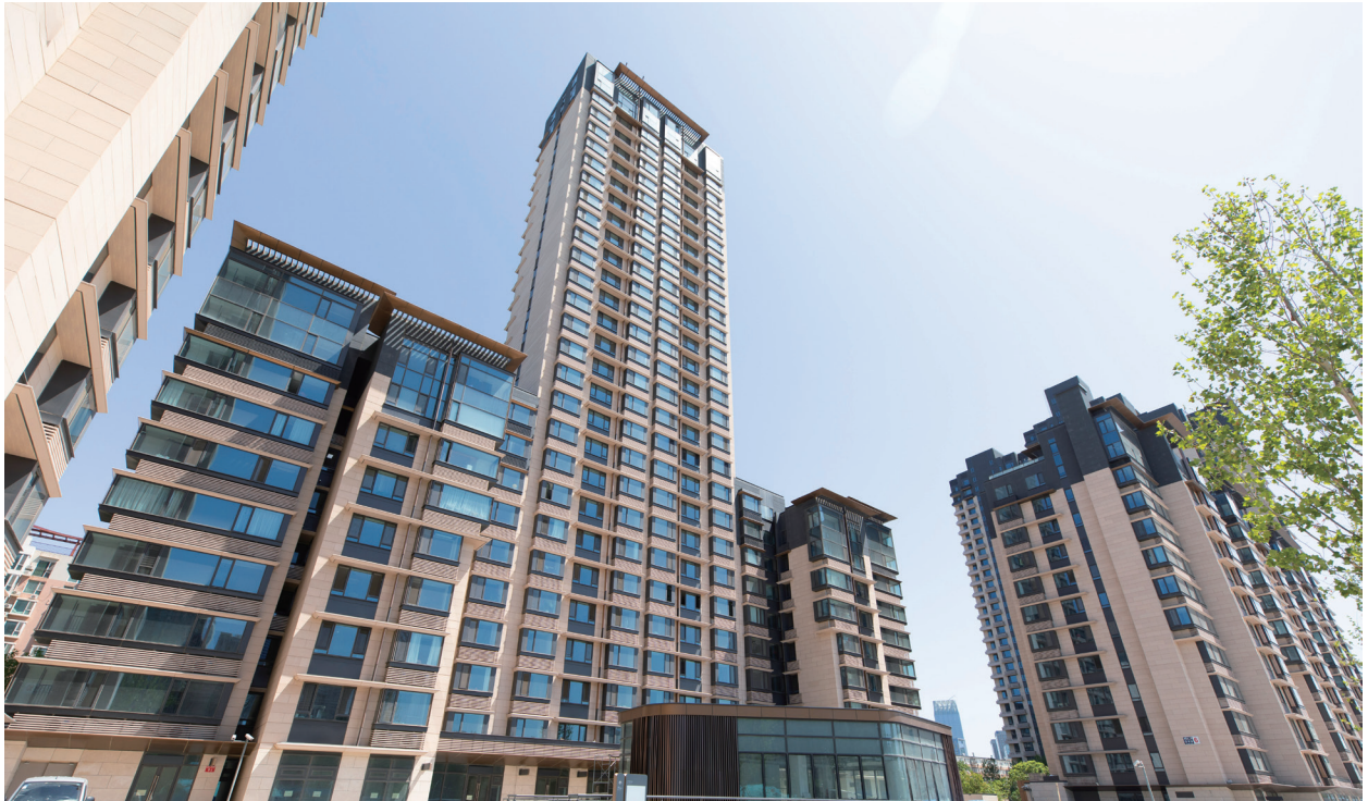
位於北京通州的「北京·東灣」發展項目
