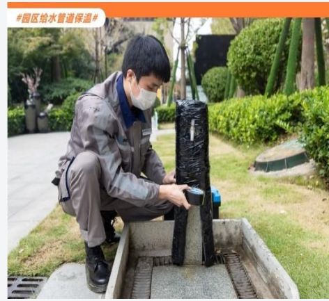
工作人員進行管道防凍作業 Worker performs antifreeze work on pipeline
