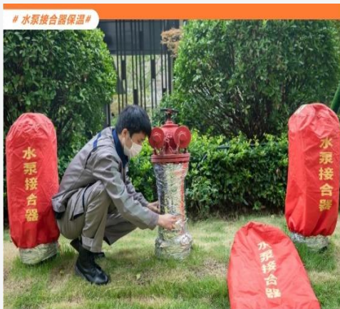
工作人員進行管道防凍作業 Worker performs antifreeze work on pipeline
