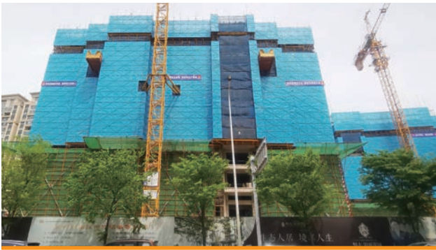
施工外圍安全設施
