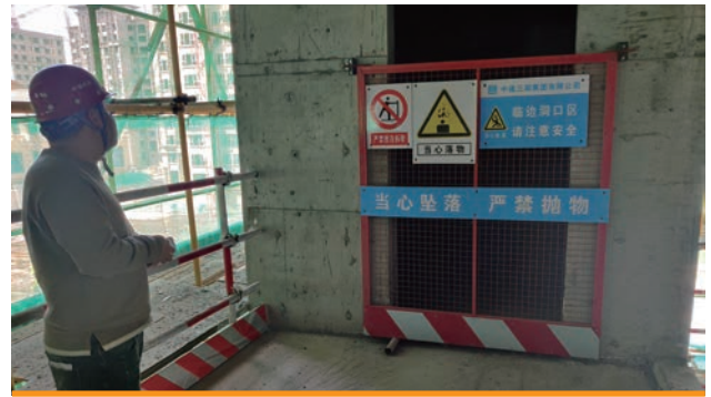
施工安全使用指引
