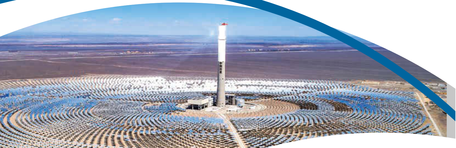
新疆哈密50兆瓦熔鹽塔式光熱發電項目
