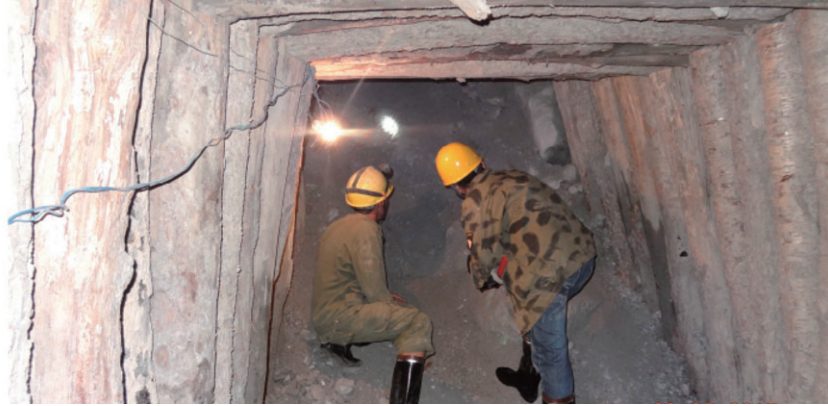
圖5-2：主幹斷裂帶的現有支護措施
