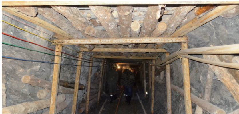
圖5-2：主幹斷裂帶的現有支護措施
