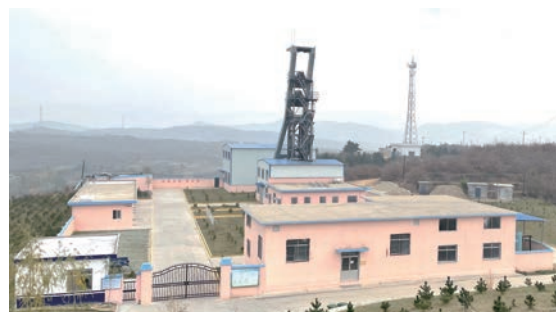
輔助豎井工地
