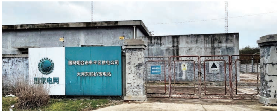
圖16-3：大河東變電站
