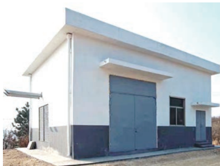
柴油發電機室
