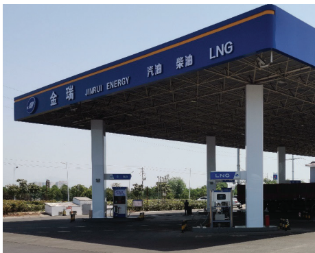
金瑞油氣綜合站
