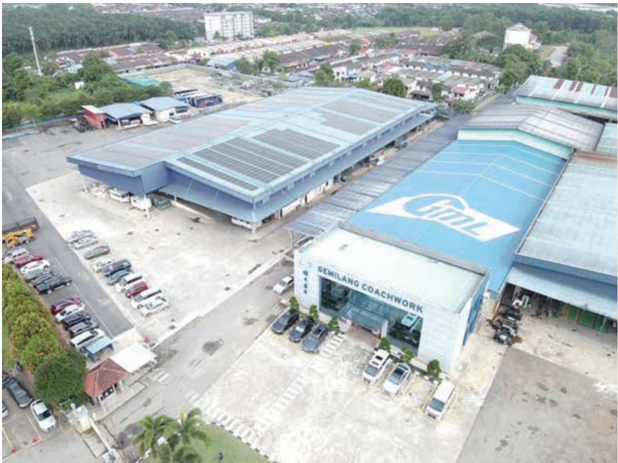
製造工場內光伏系統的照片
