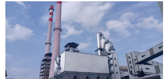
福清浮法二線熔窯煙氣脫硫脫硝除塵系統升級改造
