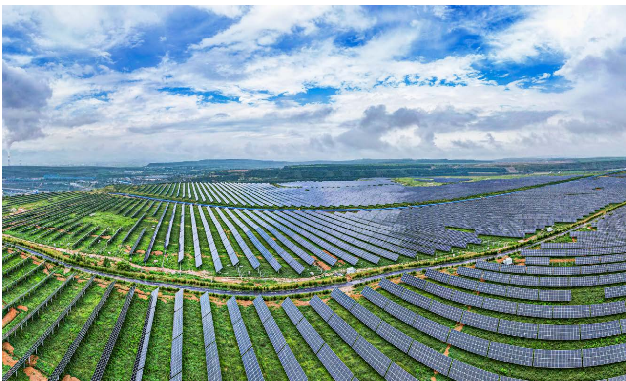
平朔集团100MW光伏项目
