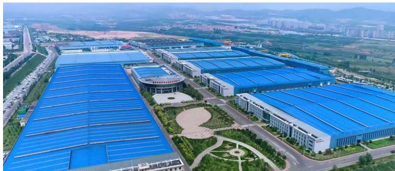
张煤机公司加快实施数字化工厂、灯塔工厂建设项目，搭建智能化车间、智能化生产线，提高生产智能化水平
