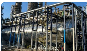
三級電脫鹽改造項目順利投用
