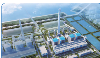
清潔高效熱電聯產機組開工
