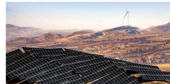
河北蔚县百万千瓦级大型风电光伏基地项目
