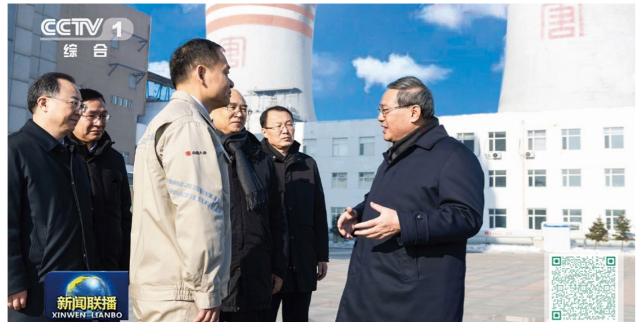
李强总理到黑龙江哈尔滨第一热电厂调研保暖保供工作
