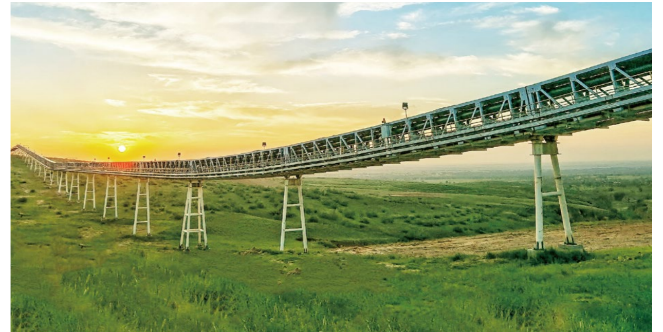
内蒙古托克托发电公司开展圈套沟项目利用管道式运输机将托电所产粉煤灰密闭输送至圈套沟小流域进行贮存和生态治理，开创了国内利用粉煤灰进行小流域综合治理的先例
