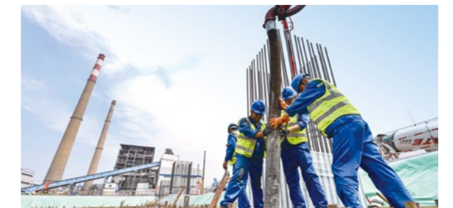
河北陡河热电公司两台66万千瓦供热机组基建项目
