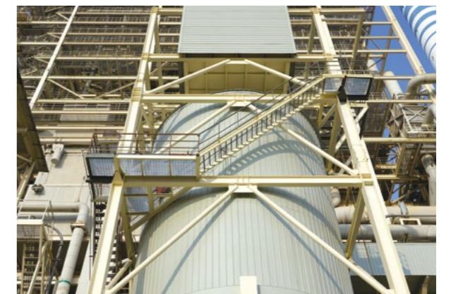
安徽当涂发电公司废水零排改造工程 2 号干燥塔系统顺利通过 168 小时试运
