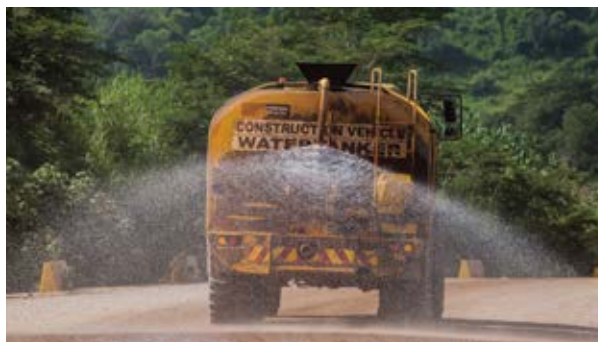
矿区道路洒水抑尘。
