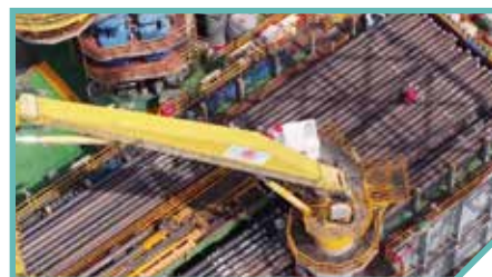
利用无人机助力安全巡检和隐患排查
