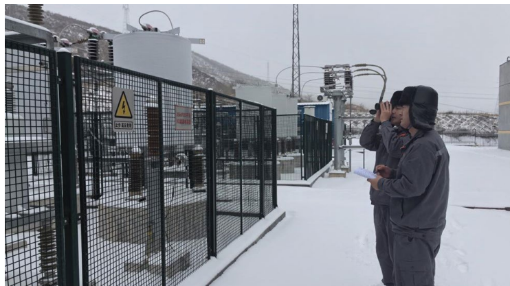
曹妃甸公司现场巡查
