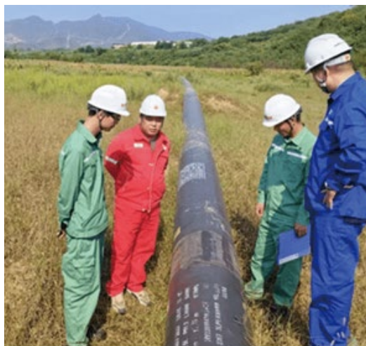
鹿泉 - 井陘输气管线项目
