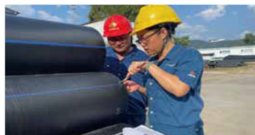
圖：德興銅業公司管道質量檢測
