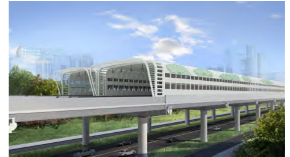
应用大跨径封闭式声屏障有效降低噪声污染（现处设计阶段）
