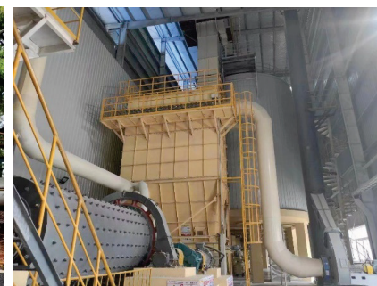
「近零廢棄物排放」工廠
