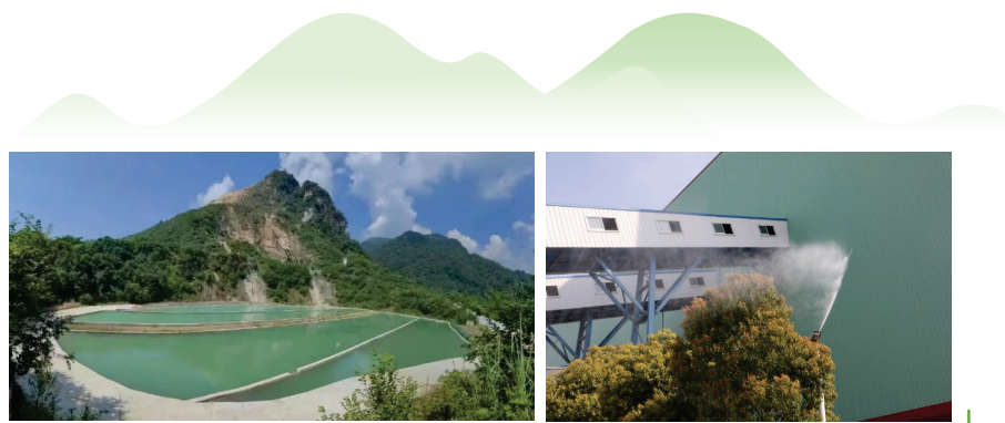
四川利森建材雨水污水循環利用系統
