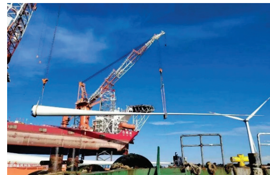
吊裝123米風電葉片
