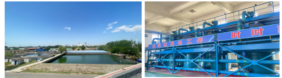
秦港股份中水厂内景
