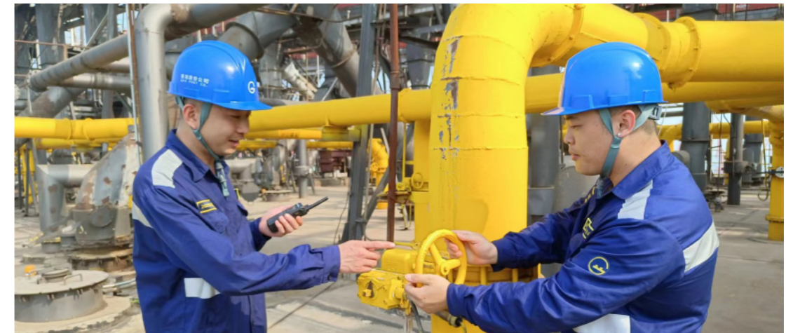
杂货公司维修班员工检查筒仓除尘系统
