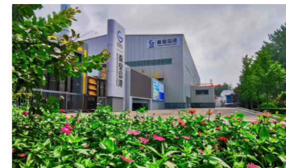
煤三期翻车机房外景
