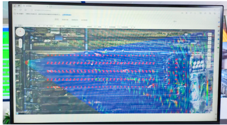
激光雷达粉尘污染监测系统对港区环境进行实时监测
