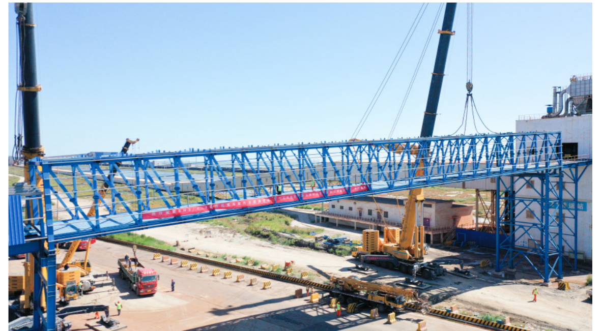
沧州矿石公司直取皮带栈桥吊装现场
